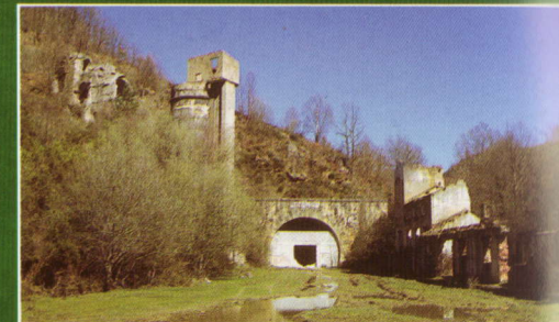
Túnel de La Engaña.
